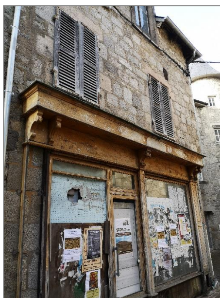
Figure 11 Photographie d'un logement ancien et vacant, rue Esparvier
