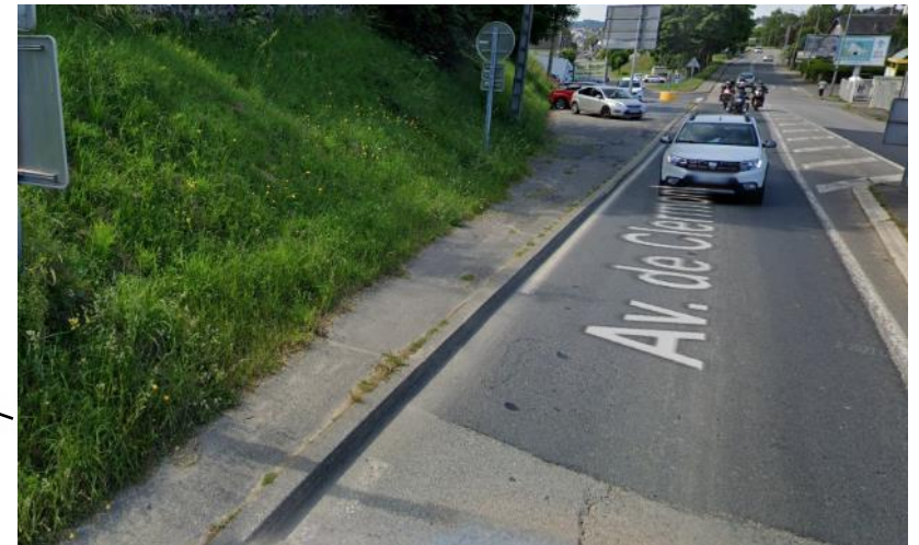
Pincement et absence de passages piétons à l'intersection de l'impasse Jean Jaurès.
