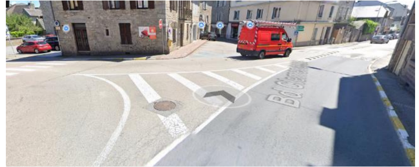
Entrée de bourg routière dévalorisante, dangereuse pour les piétons à la croisée de la rue du Général de Gaulle.
